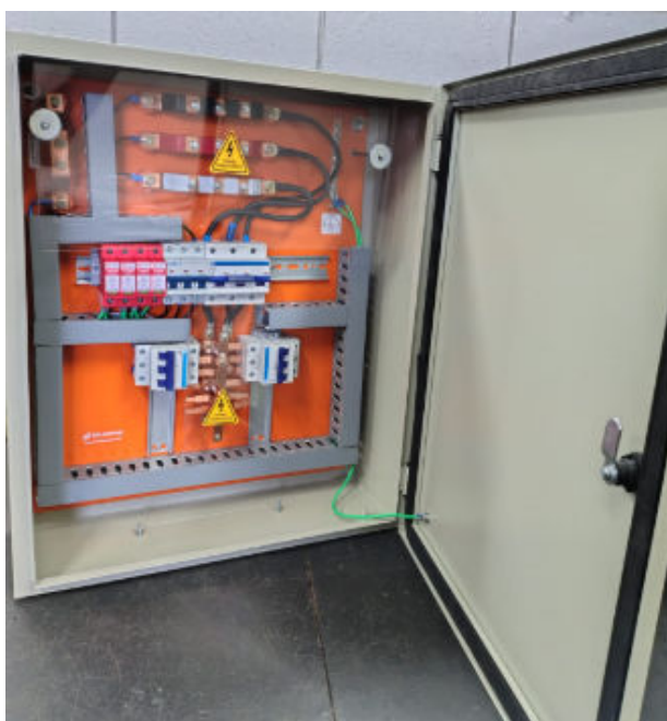
Figura 3.4. Modelos de QDG – Quadro de Distribuição Geral – Padrão Strazmaq.
